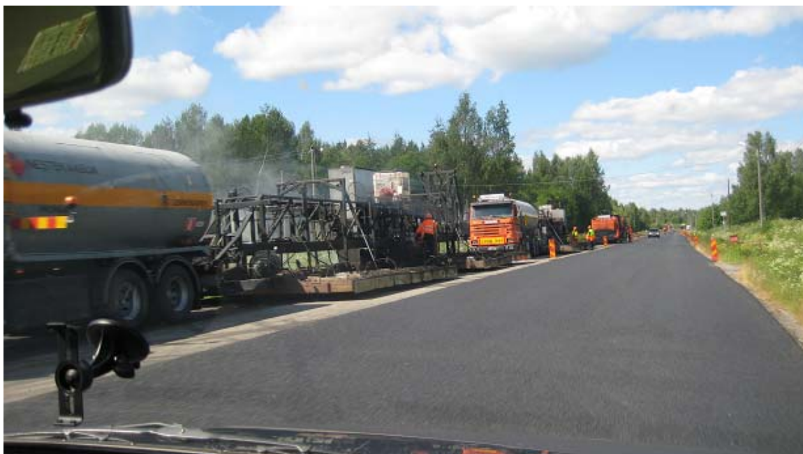
Figur 10. Asfaltmaskiner i körfält närmast trafikanterna.
