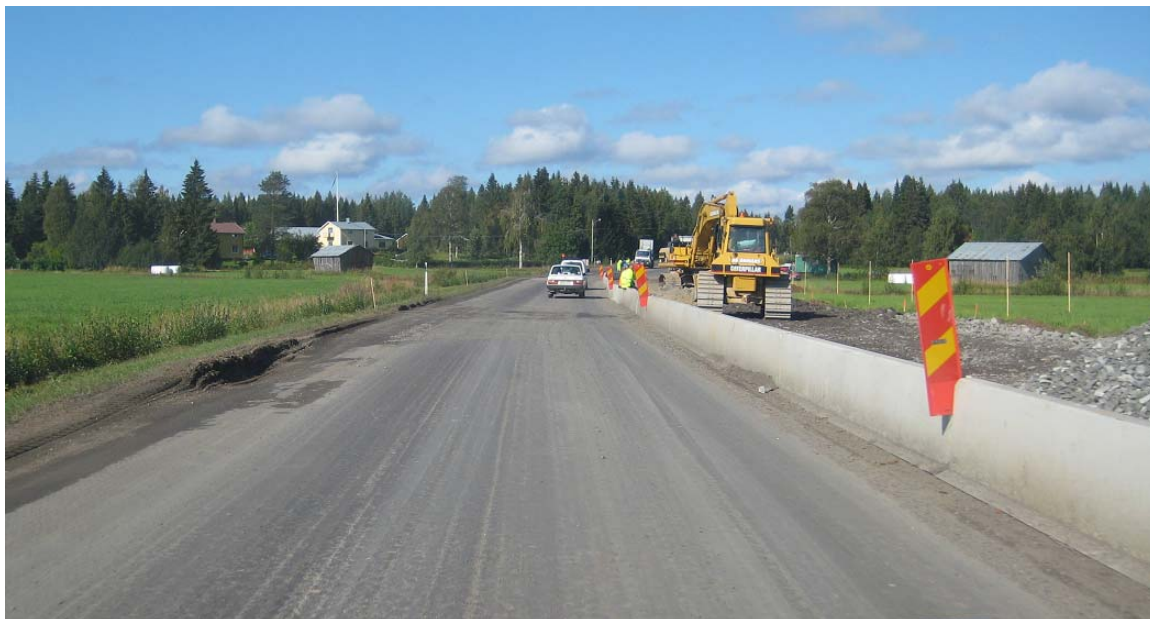
Figur 19. Betongbarriär E4 Kalix.
