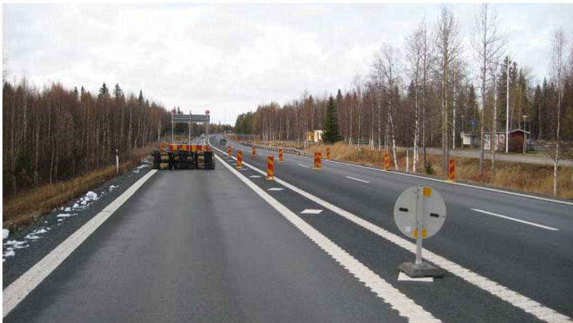
Figur 4. Vëgarbete E4 Haparanda, vy mot väster.
