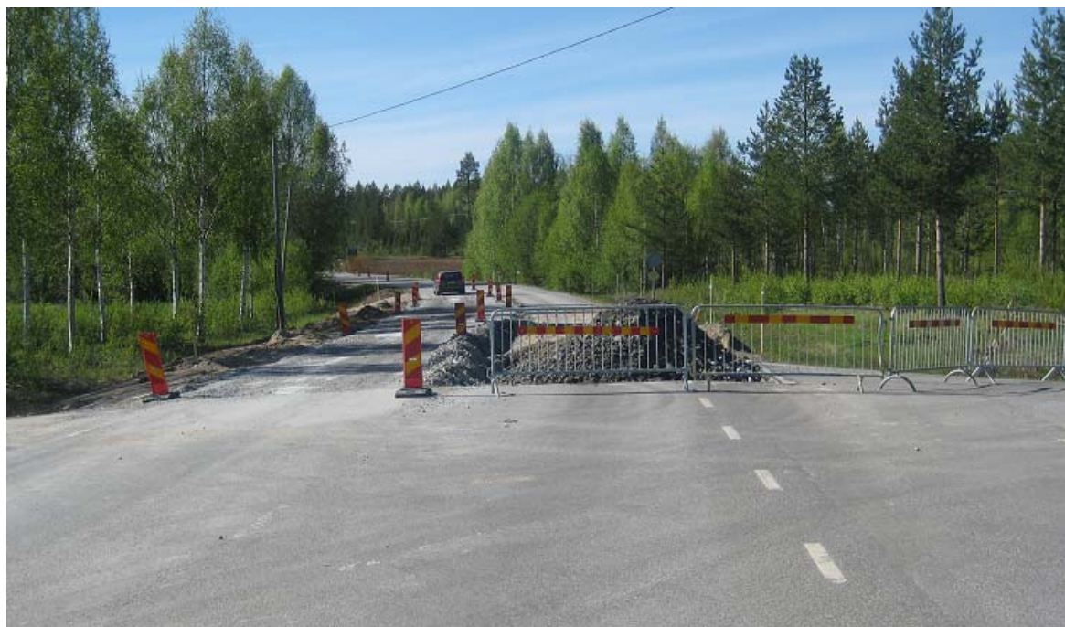
Figur 18. Schaktarbeten på väg 509 Öjebyn.
