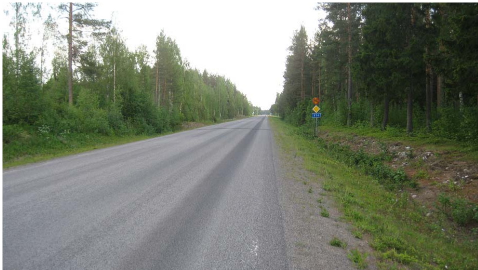
Figur 14. Plats 2 väg 374, hela vägytan belagd.
