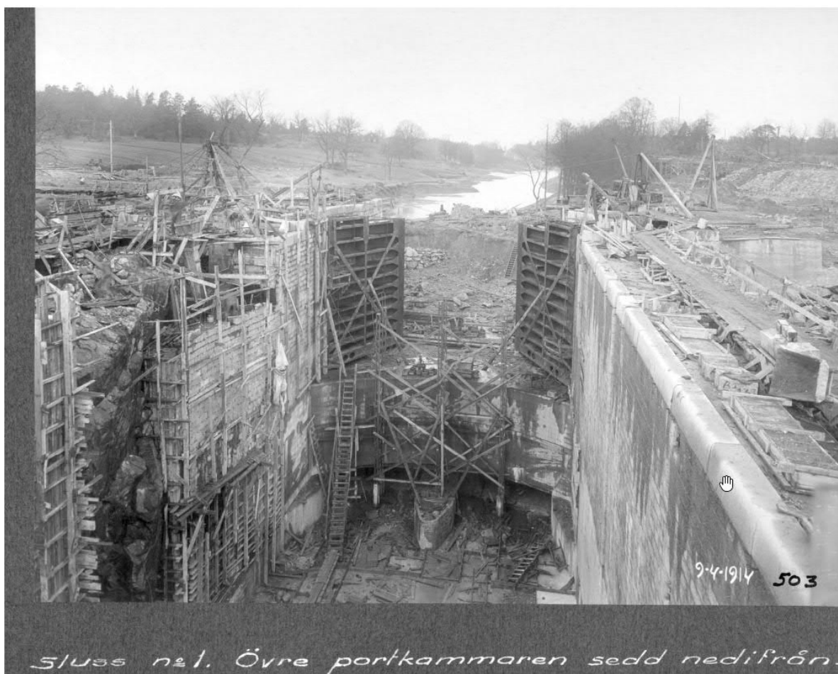
Figur 2. Byggnation av 1916 sluss
