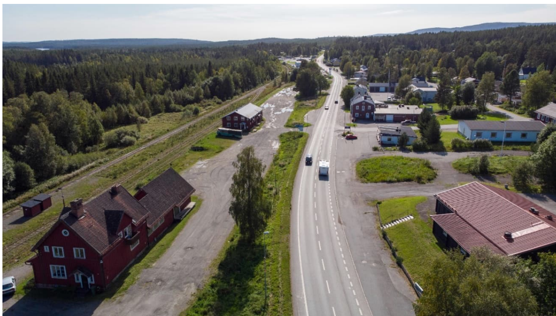
Figur 11. Infrastrukturen med E45 och Inlandsbanan
