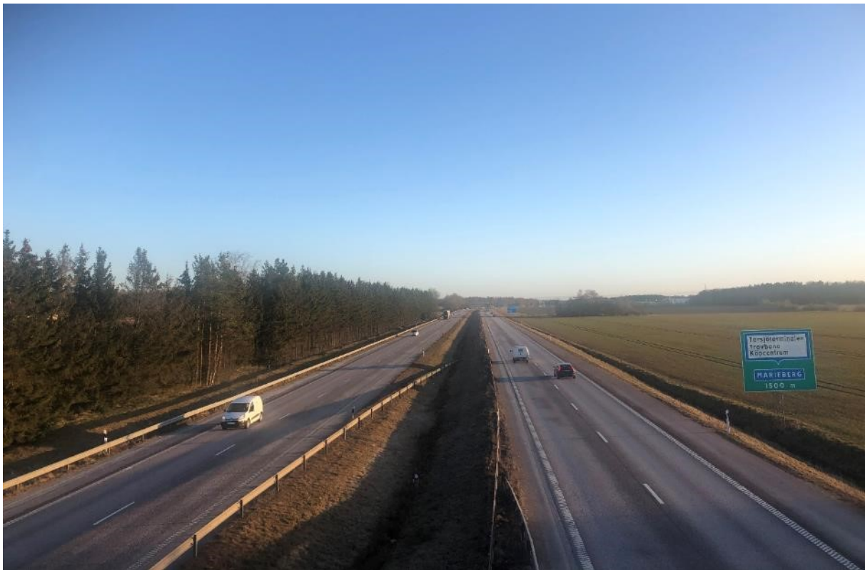
Figur 4. Foto mot norr där väg 540 korsar E20.
