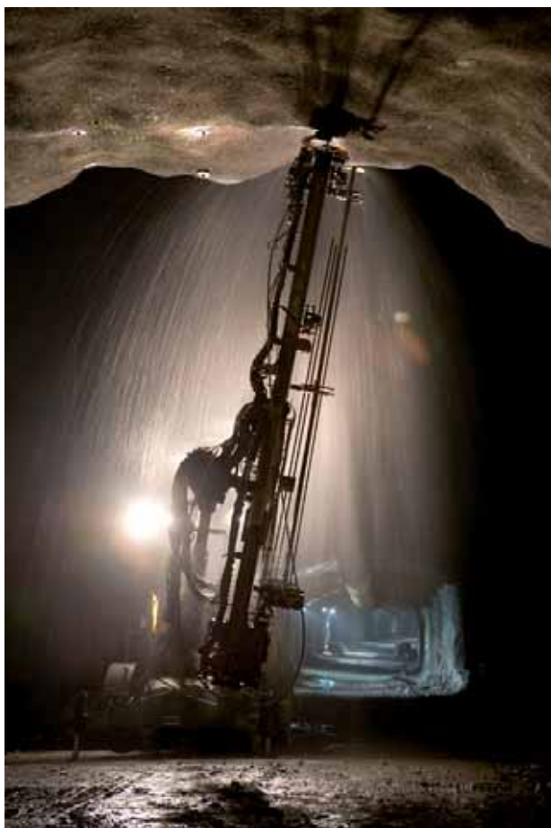
Figur 12.1 Tättningsarbeten vid byggandet av Norra länken.
