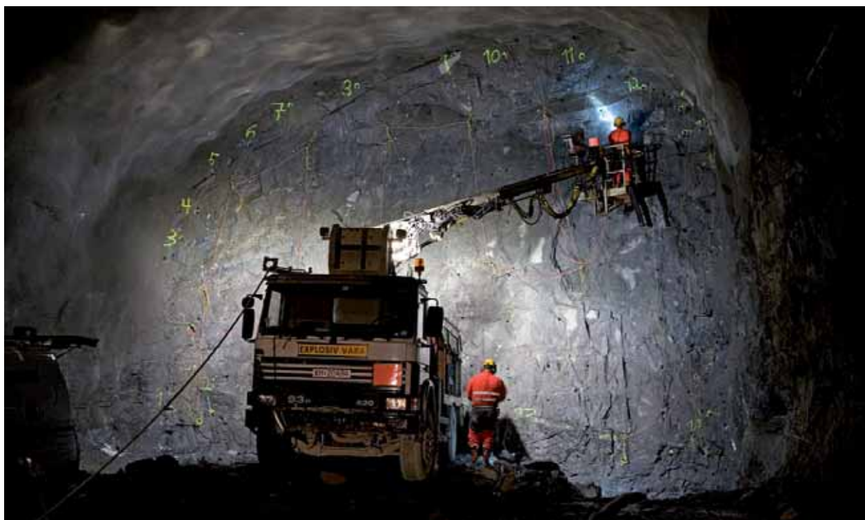
Figur 12.6 Tunneldrivning i Norra länken.
