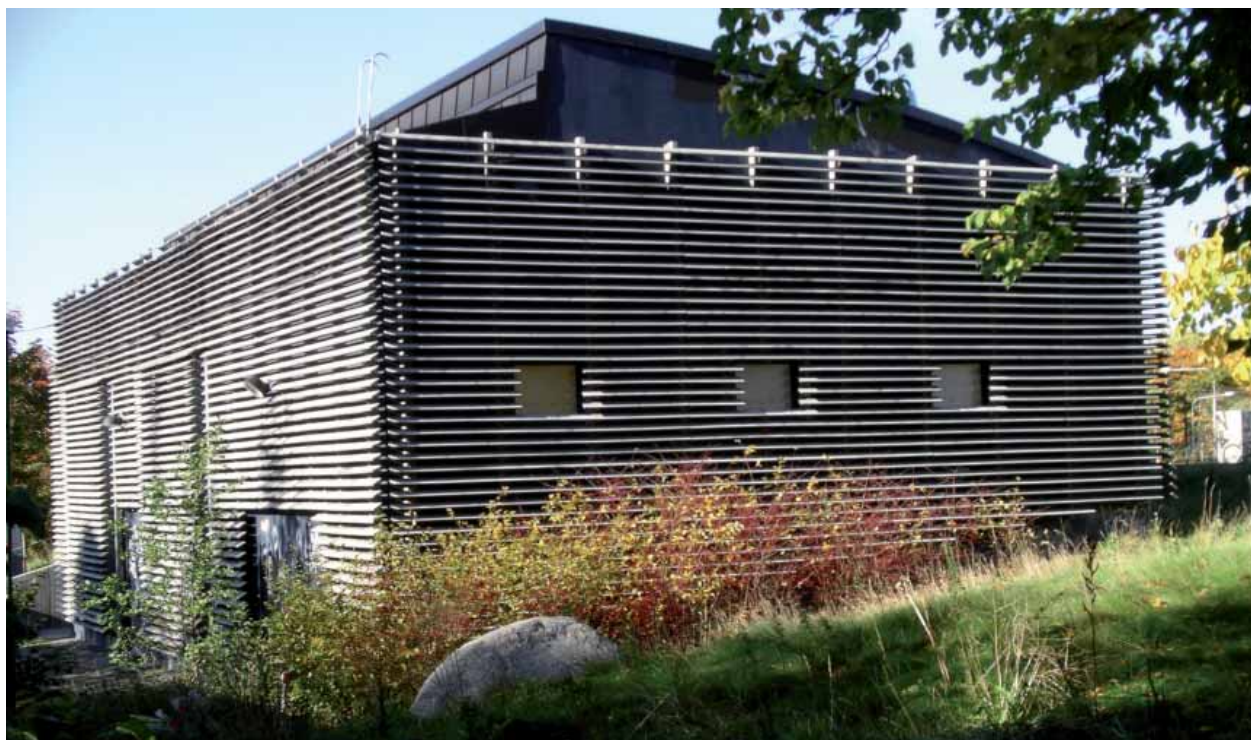
Figur 8.7 Exempel på mottagningsstation vid Södra Länken.
