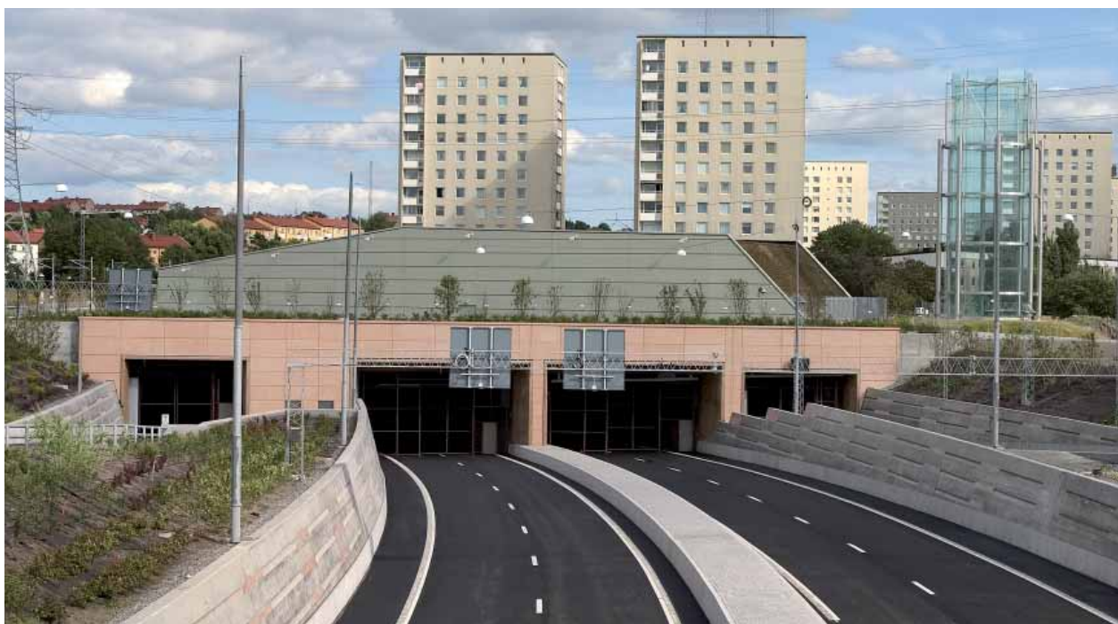
Figur 8.6 Exempel på frånluftstorn vid tunneldrift till höger om Södra Länken i Stockholm.
