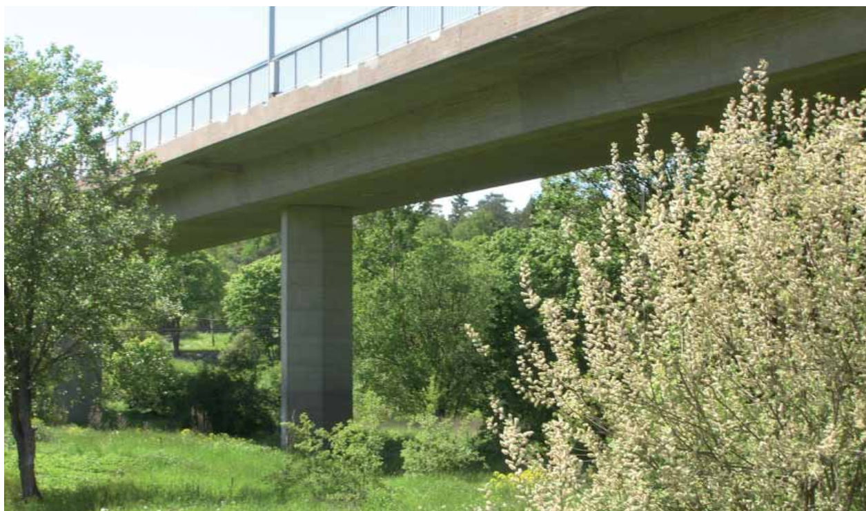
Figur 19.13 Bergslagsvägens passage över Spångadalen och Spångaån/Bällstaån.
