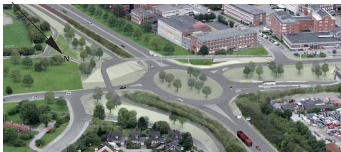
Figur 18.3 Den norra påfarten vid Vinsta, sedd från norr. Fotomontage ur gestaltningsprogram.
