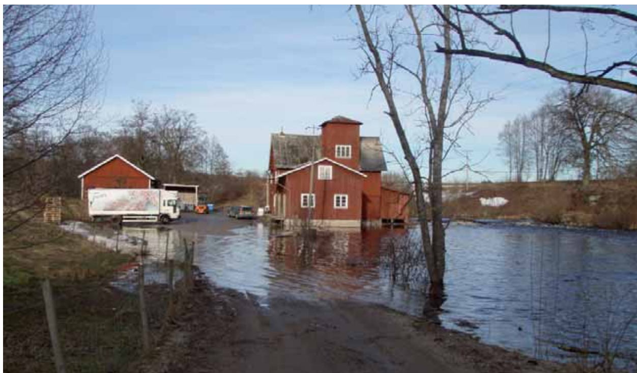
Figur 14.1 Ökade risk för översvämning är en av klimateffektens förväntade konsekvenser. Foto: Ida Torstensson.
