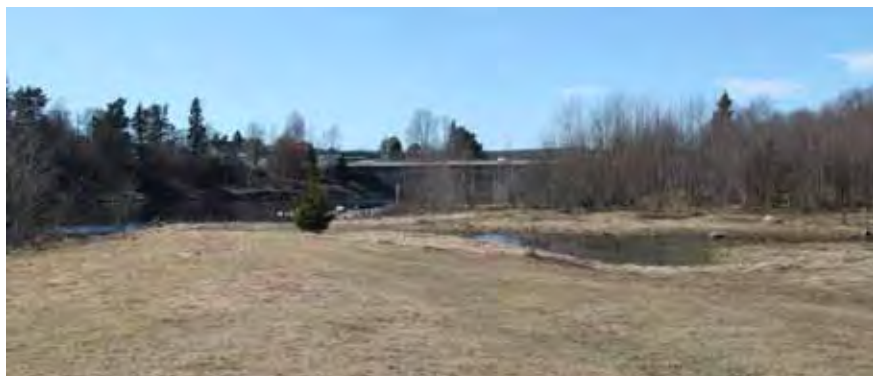
Figur 2.4 visar exempel på åskådarperspektiv och hur en betraktare i landskapet uppfattar väganläggningen på håll. Här vägbron över Ljungan för nuvarande E4 sett från öster.
