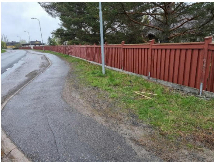
Figur 17. Befintligt bullerplank som finns beläget utmed den södra sidan av Centrumvägen mellan Vårdhemsvägen och Sörviksgatan.
