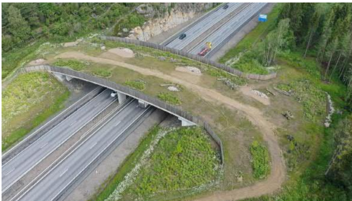
Figur 41. Exempel på ekoduktutformning från E6 Sandsjöbacka som visar biotopsytor och planteringar.
