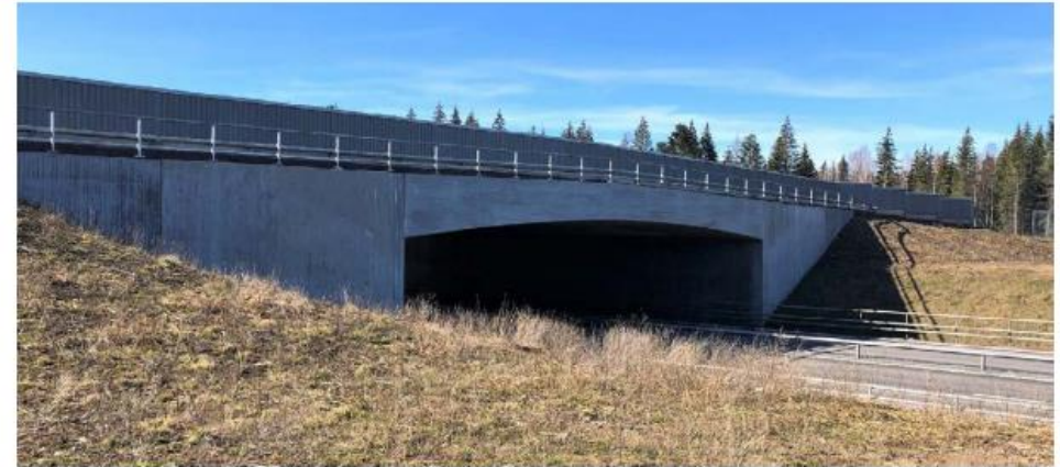
Figur 28. Faunabron vid Hova (knr: 100-296-1). Brons spännvidd över E20 är 26 m. Foto från BaTMan.
