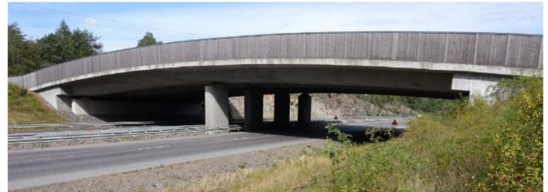
Figur 26. Ur gestaltningssynpunkt är det viktigt att faunaskärmen ansluter väl till landskapet och att den inte upplevs för hög ur trafikantsynpunkt. Foto från Ekodukt Sandsjöbacka, Mats Lindqvist
