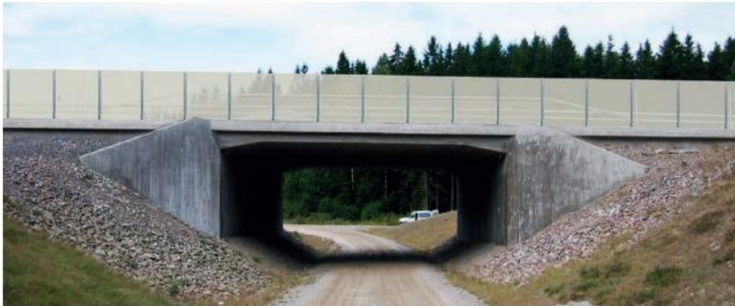
Figur 7 Illustration av tänkbar lösning med siktskärm på befintlig port. Siktskärmen skall dock inte vara transparent som i denna illustration ovan. Illustration Enviroplanning AB
