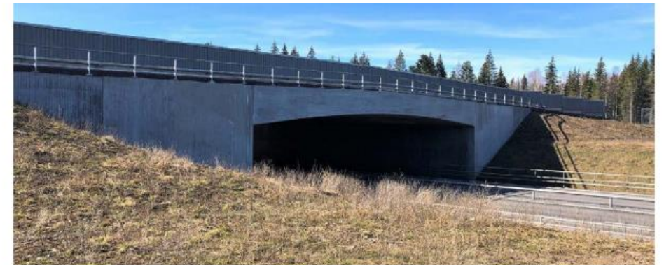
Foto: Faunbro vid Hova på E20, exempel på rambro i betong.
