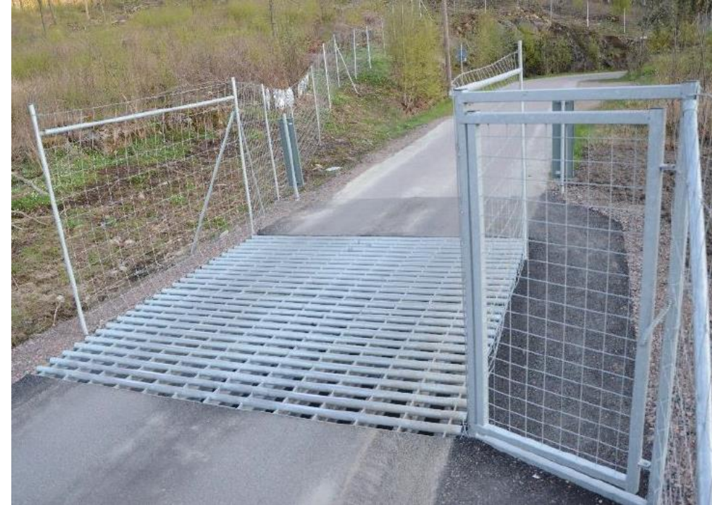
Figur 6 Färister används i stängselöppningar på enskilda vägar för att förhindra att djur tar sig in på vägområdet. Här en färister över en enskild väg kombinerad med grind. Färisten kan bestå av ett gallersystem som framför allt klövdjur undviker att gå över.
