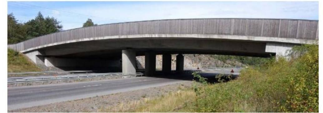
Foton: Ekodukt vid E6 Sandsjöbacka, exempel på betongbro.
