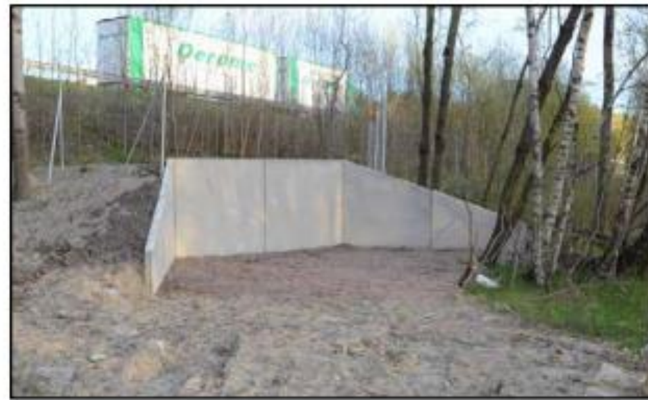
Figur 4 visar exempel på viltuthopp i betong vid E6 Sandsjöbacka där höjden är ca 1,8 m högt.
