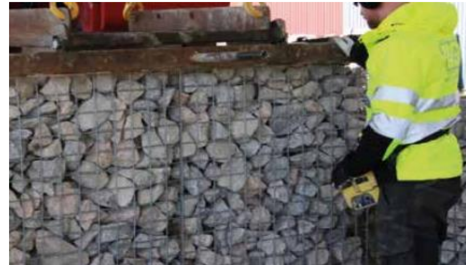
Figur 5 nedan visar exempel på material till gabionmurar, dvs nätkassar i metall som fylls av stenmaterial, och byggs upp i moduler till ett viltuthopp. Ovansidan måste beläggas med grästorv/växtbädd eller liknande för att faunan inte ska skada sig och fastna i nätet.
