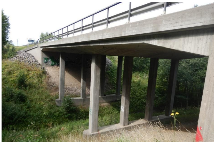
Figur 2. Bron över Håttorpsån skall förses med en ca 1,1 m hög siktskärm av acrylat för att minska störningar från trafiken.
