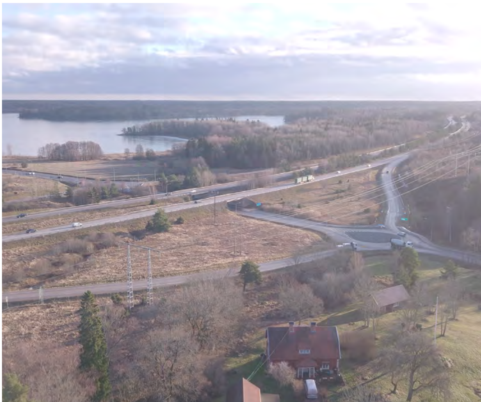
Figur 32. Vy från Ar mot Trafikplats Brunnby.
