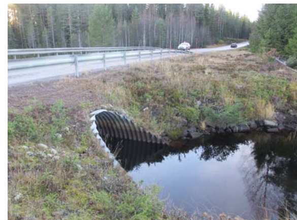
Bild 12. Vägtrumma under väg 1024 där vägområdet är återetablerat med naturlig vegetation
