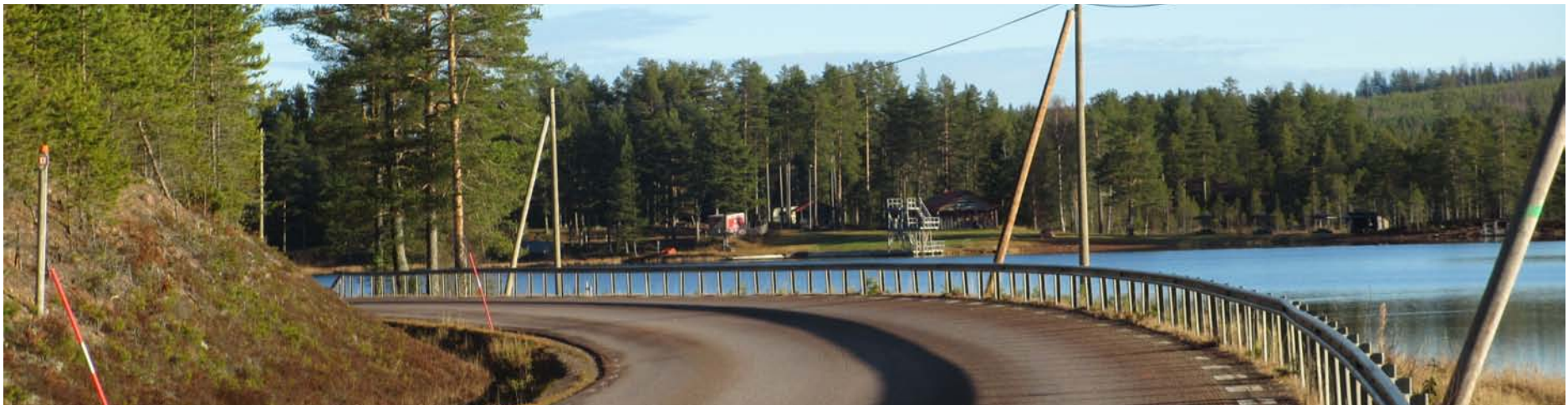
Bild 3. Exempel på linjeföring där vägutrustning och vegetation ger visuell ledning
