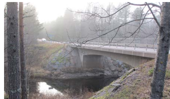
Bild 18. Bro med erosionsskydd av sprängsten
