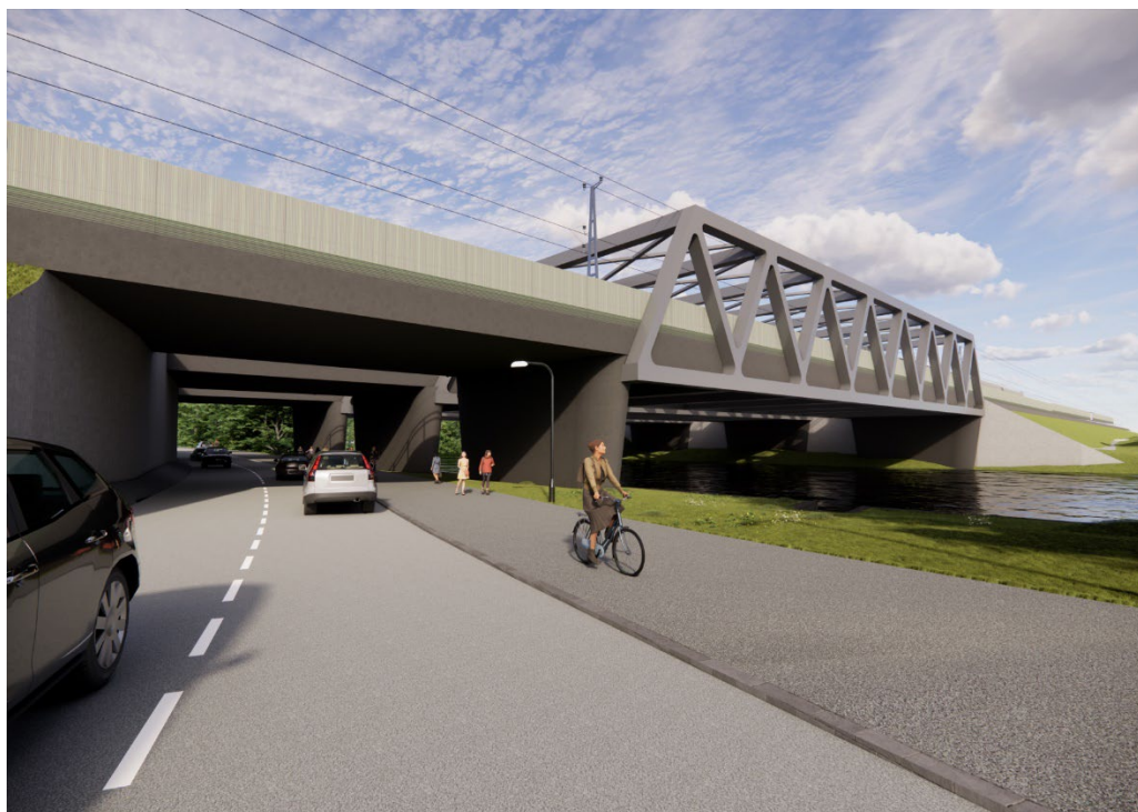
Figur 28 Visualisering av hur ny järnvägsbro över Stångån skulle kunna se ut med gång- och cykelväg samt bilväg under bron. Bilden visar exempel på en så kallad fackverksbro.
