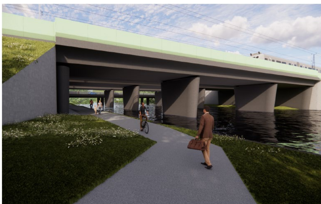
Figur 30 Visualisering av hur ny järnvägsbro över Stångån skulle kunna se ut med gång- och cykelväg under bron. Bilden visar exempel på en så kallad balkbro med brostöd i vattnet.
