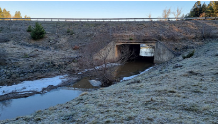
Figur 7.40 Kumlaåns passage under E4
