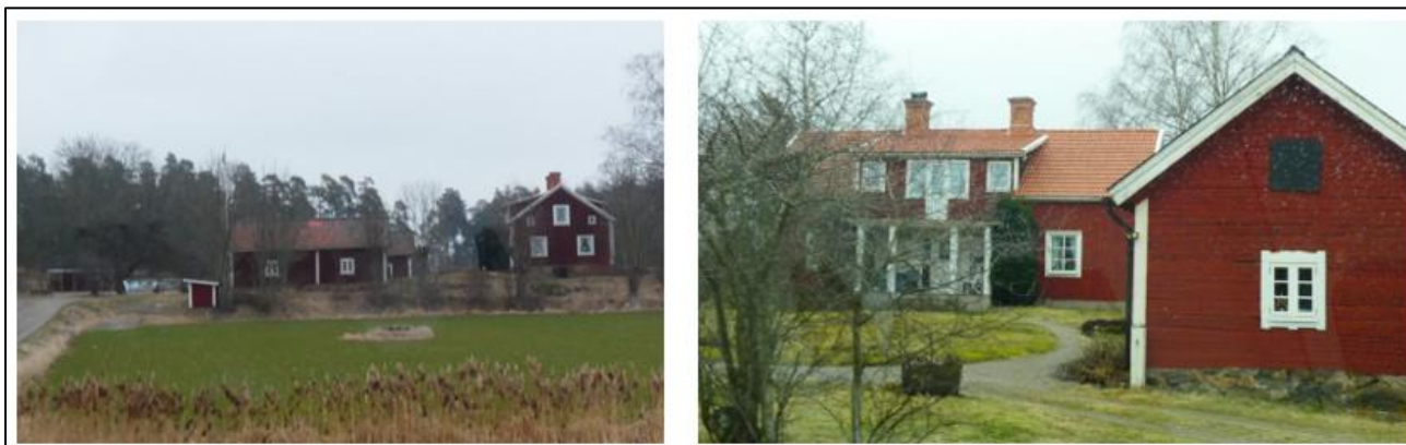
Figur 33. Herrbeta 1:17, fasad vinkelrätt Ostlänken (till vänster) och till höger skyddad uteplats ”på innergård”.
