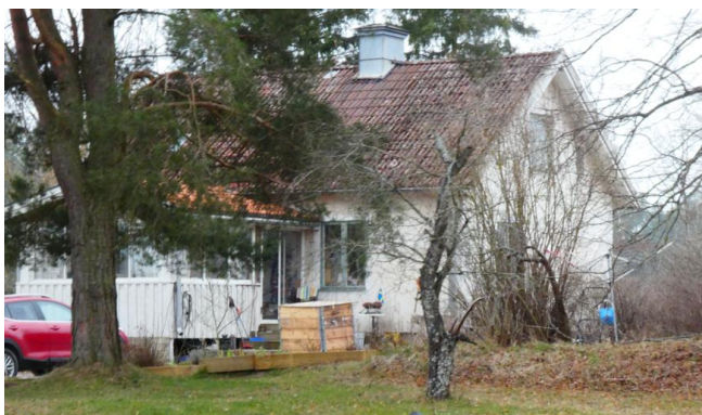
Figur 21. Bullerberörda bostadsbyggnader på Markeby 1:11 hus 1u
