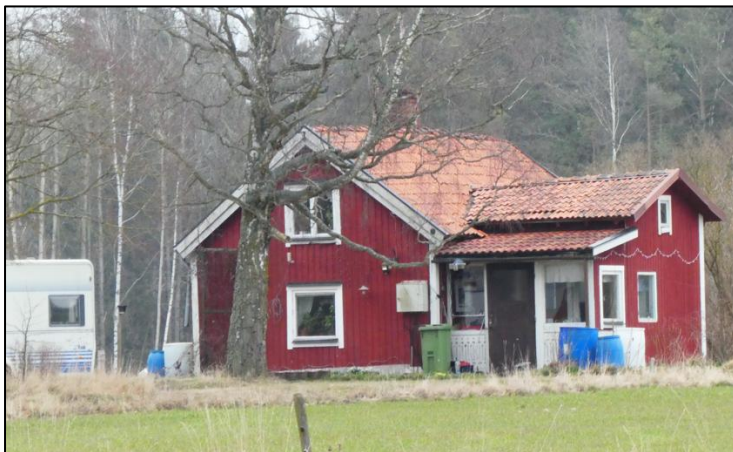
Figur 25. Foto på bostadsbyggnad på fastigheten Markeby 1:19
