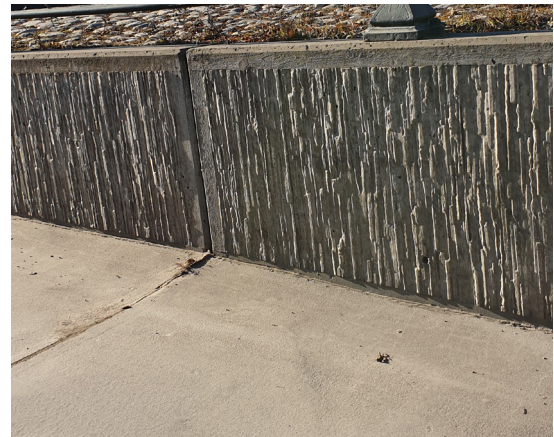
Figur 3.9 Strukturbetong tillför variation och djup till betongytorna.
