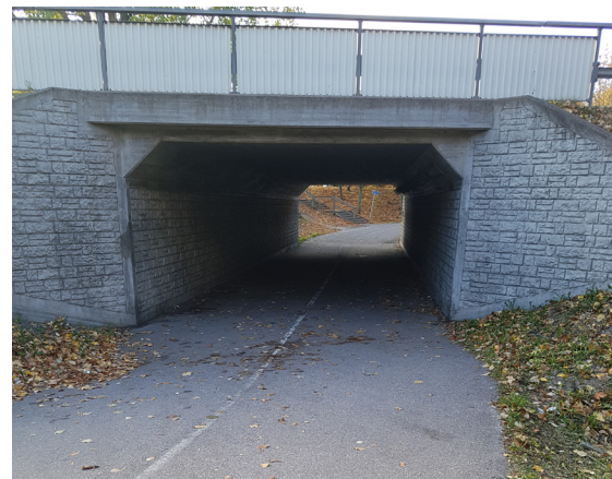
Figur 3.10 Exempel på gc-port med strukturbetong.
