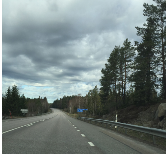
Figur 3.7 Befintliga räcken längs den aktuella sträckan av väg 56 utgörs av både w-profilräcken och vajerräcken.
