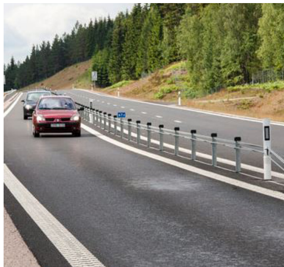
Figur 3.8 Vajerräcken är mindre påtagliga och ger ett mjukare intryck i vägrummet. Foto: ATA
