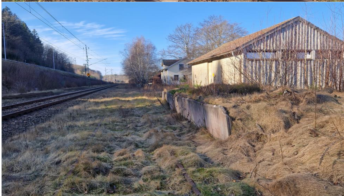
Figur 4.4.2–2. Övre bild: Stationshuset (vit byggnad) och godsmagasinet (röd byggnad) i Knäred (Länsstyrelsen Halland, 2023). Det röda godsmagasinet har senare flyttats in på tomten vid stationshuset. Nedre bild: Det gulmålade magasinet byggt innan 1957 som står kvar på ursprunglig plats. Till höger i bild syns lastkajen och det övervuxna stickspåret.
