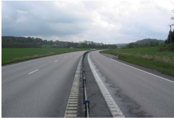
Väg med mittseparering (2+1-väg).
