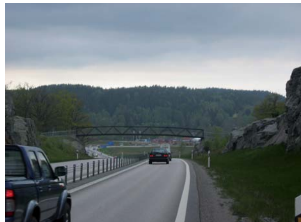
Bro över väg med mittseparering.
