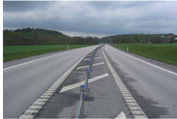
Väg med mittseparering (1+1-väg).
