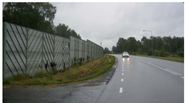
Bullerskärm utmed befintlig väg vid Säröleden.
