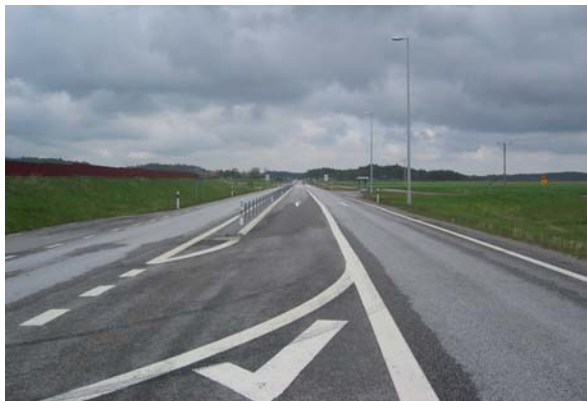
Väg med mittseparering (2+1-väg).
