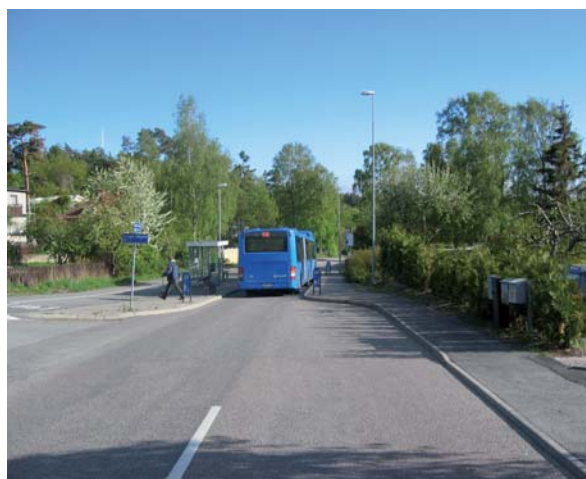
Timglashållplats - båda riktningarna blockerade.
