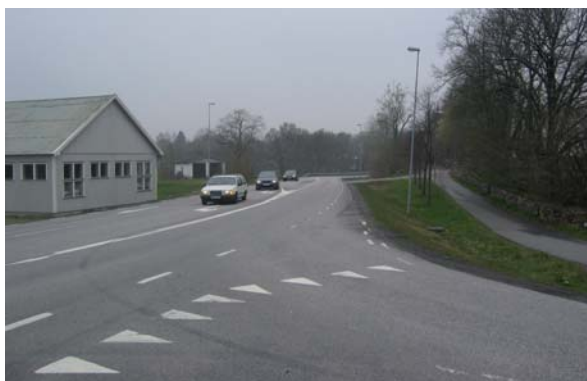
Korsning väg 940 - väg 942.
