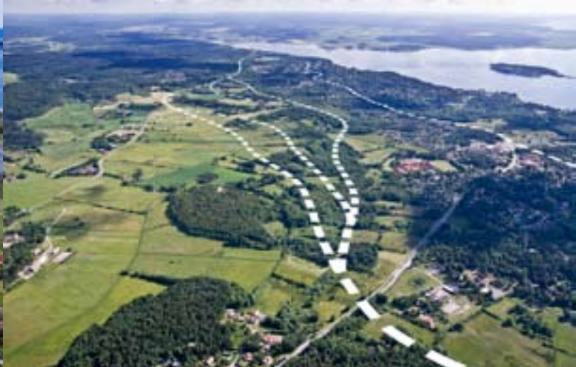
Utredningsområdet sett från Mariedalsvägen mot norr (Forsbäck) med alternativen 1-4 som alla ligger väster om Onsala tätbebyggelse och Förbättrad Befintlig Väg.
