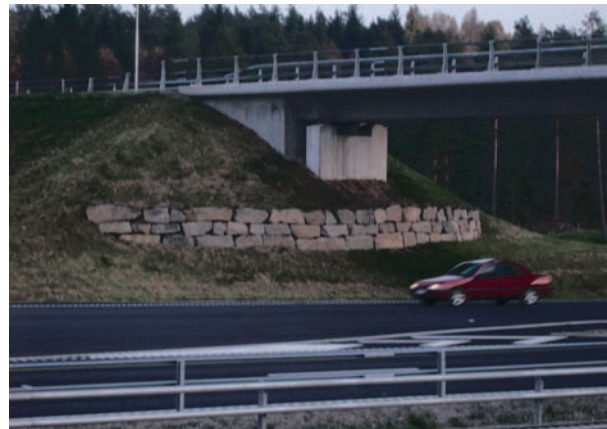
Enkel och snygg avslutning på brostöd genom terrassering av jordslänt med större sten, i skogig miljö.
