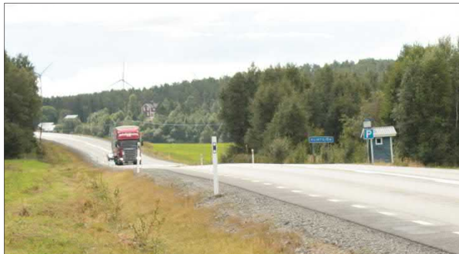
Figur 38. Busshållplats Vallen - södergående. Hållplats på parkeringsficka.
