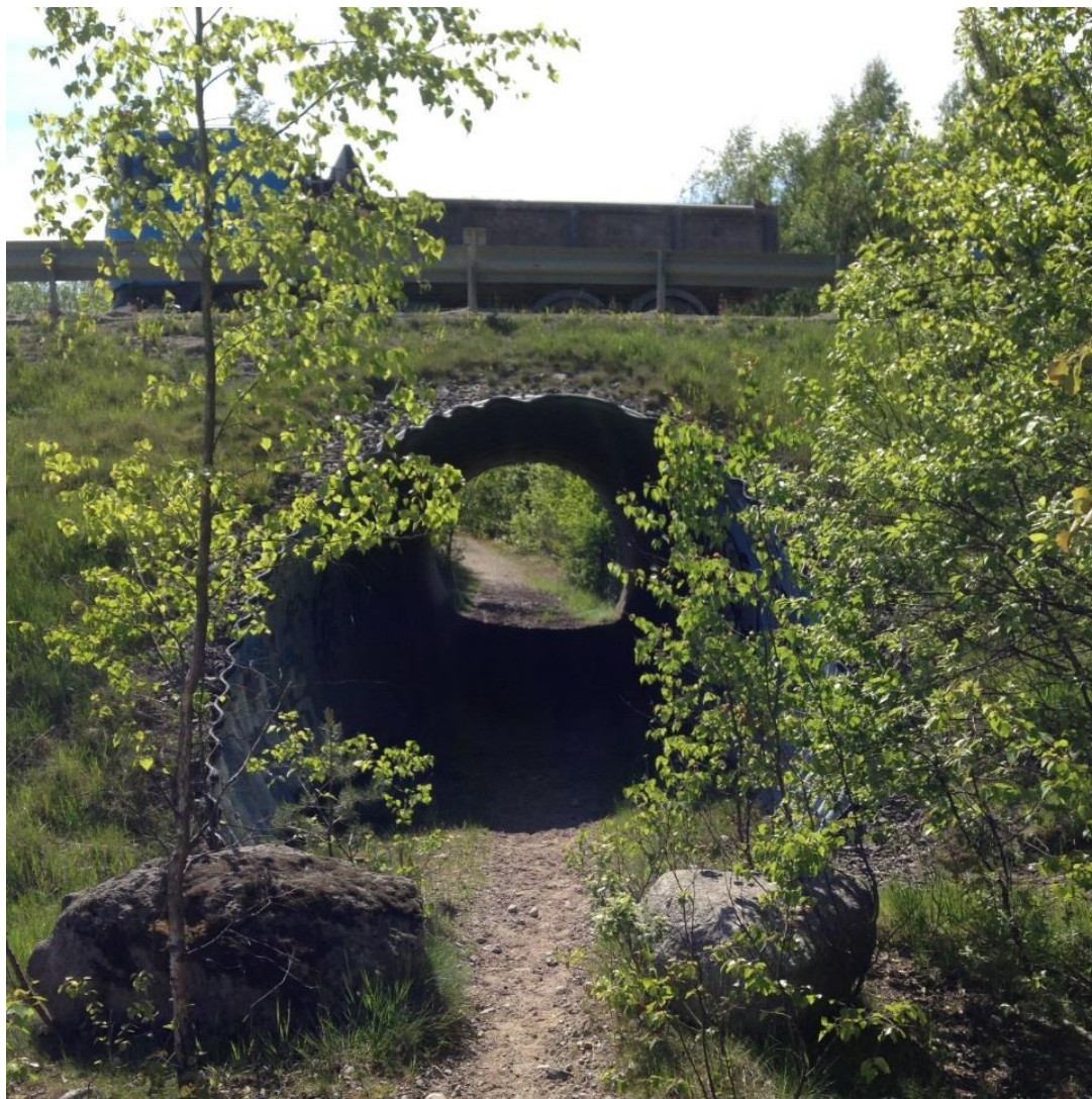
Figur 12. Rörbro under väg 560. Används främst av ryttare från Fors Gård.
