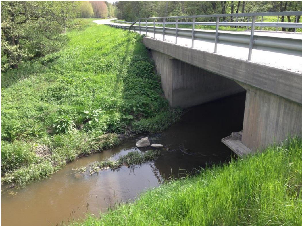
Figur 19. Södra passagen över Vitsån. Utterpassagen skimtar ovan vattenytan vid brostödet närmast i bild..
