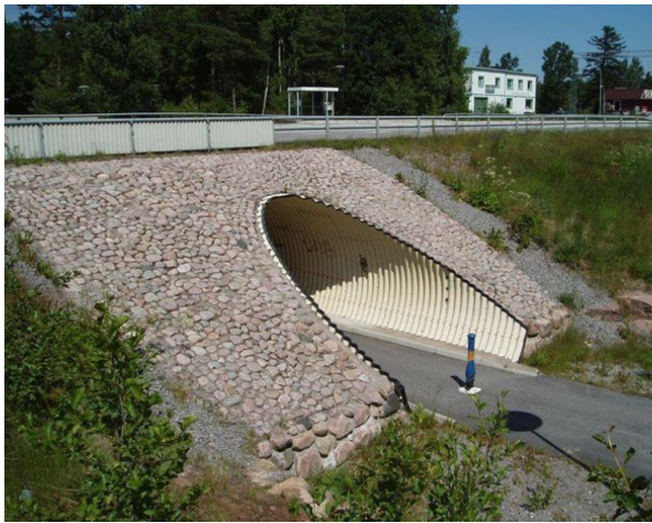
Rörbro över GC-väg vid Lugnås
