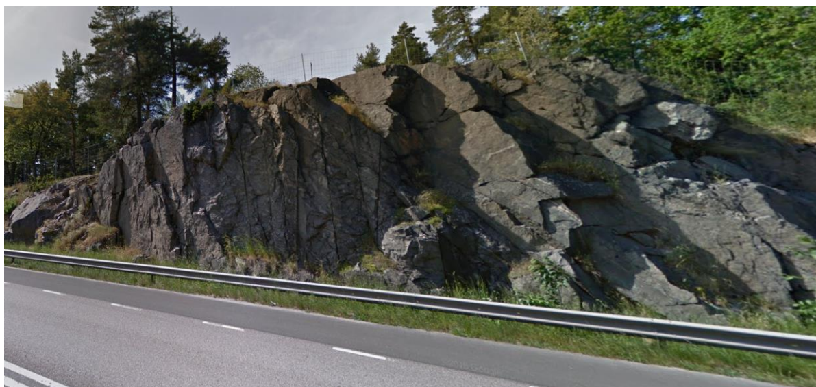
Figur 3.6.3.1 Befintlig bergskärning vid planerad faunabro.
