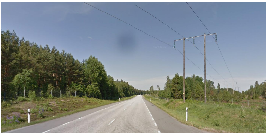
Figur 3.6.5.1 Korsning befintlig E20 och högspänningsledning.
