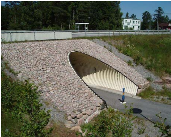
Rörbro över GC-väg vid Lugnås
