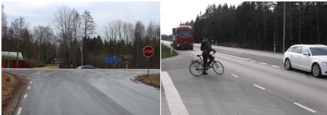
Figur 10: ”Halvfarakorset”, korsningen mellan E20 och väg 2730 vid Halvfaran/Lilla Moholm, en av alla korsningar i plan längs med nuvarande E20 där oskyddade trafikanter korsar över E20.
