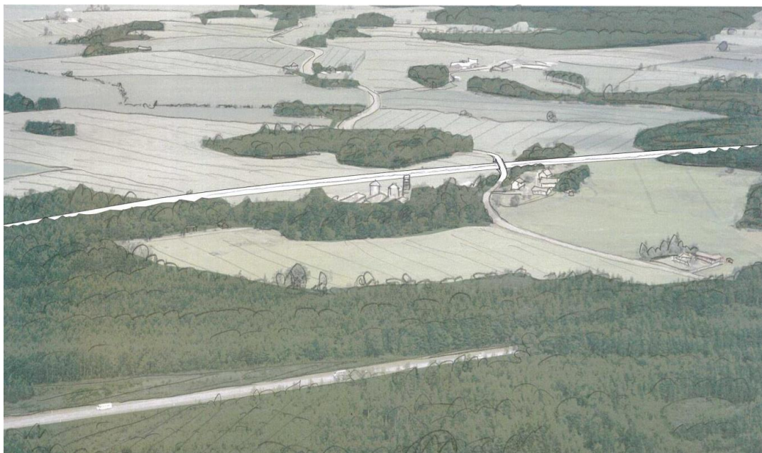
Figur 42: Flygperspektiv över möjlig vägsträckning i grön korridor vid Halvfaran. Lokalväg på bro över huvudväg i närhet av gårdsmijöer.
