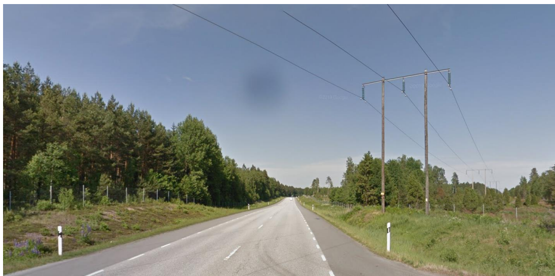
Figur 3.6.5.1 Korsning befintlig E20 och högspänningsledning.
