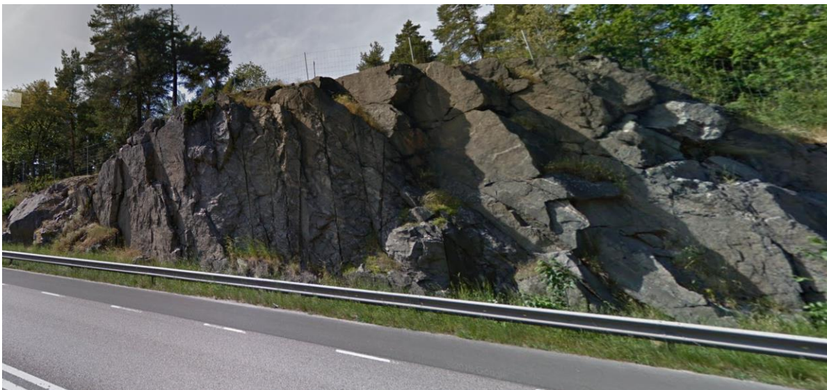
Figur 3.6.3.1 Befintlig bergskärning vid planerad faunabro.
