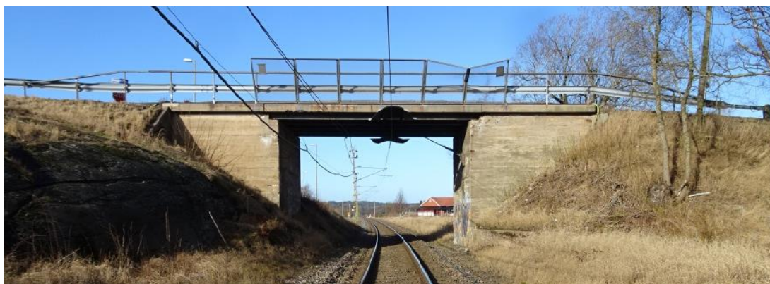
Figur 20. Vy, Befintlig bro över järnväg vid Gunnesby.
