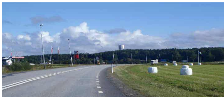
E4 genom Änåset; en landsväg som följer terrängen väl med ett körfält i vardera riktningen.
