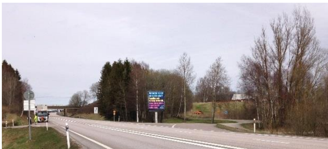
Figur 10 - E20 korsar äldre vägsträckning vid Hobergs by.
