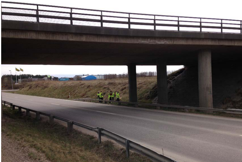
Figur 14. Befintlig bro under E20 vid trafikplats Vårgårda.
