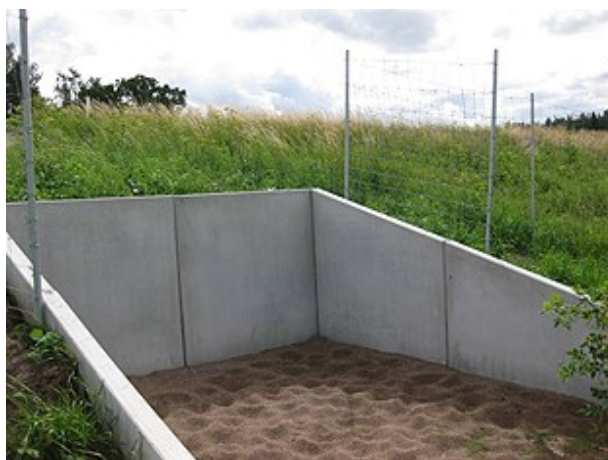
Figur 8. Illustration av funktionen viltuthopp.
