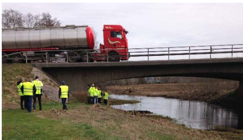
Figur 17. Bro över Sävån, torr passage vid strandkant.
