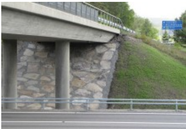
Figur 10. Stenläggning av ordnad sprängsten i grus i kombination med vegetationsklädda brokoner föreslås även under de befintliga broar som åtgärdas.
