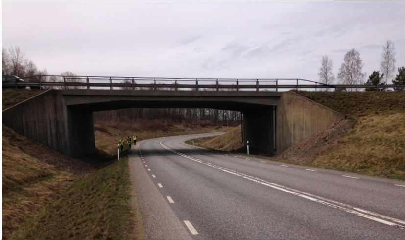
Figur 13. Befintlig bro under E20 vid Hjultorp. Även befintliga slänter täcks med jord och besås.
