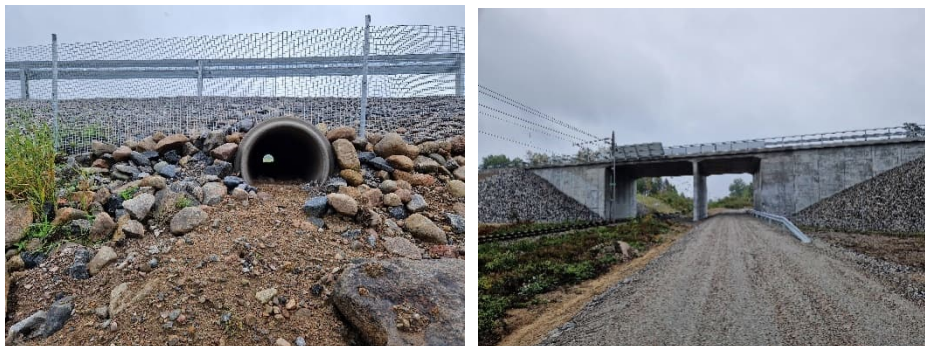
Figur 4. Torrtrumma under väg samt faunapassage utmed enskild väg som går parallellt med järnvägen.
