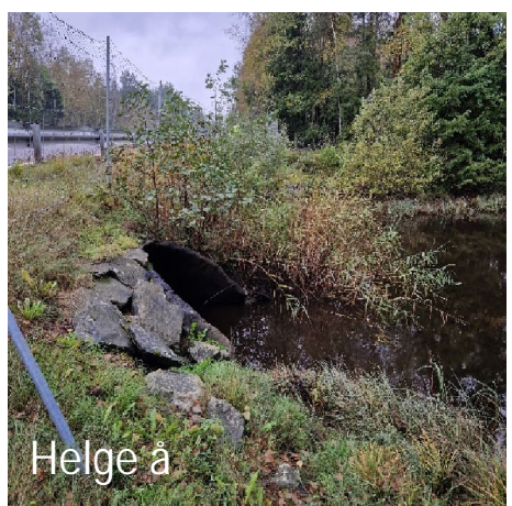
Figur 23. Broar över vattendrag längs med sträckan. Helge å passerar genom två rörbroar under väg 25 (endast ett syns i bild).
