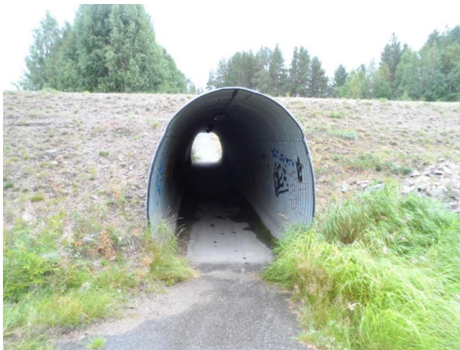
Figur 3.7.3. - Bro 25-1944-1, Foto BatMan Trafikverket.
