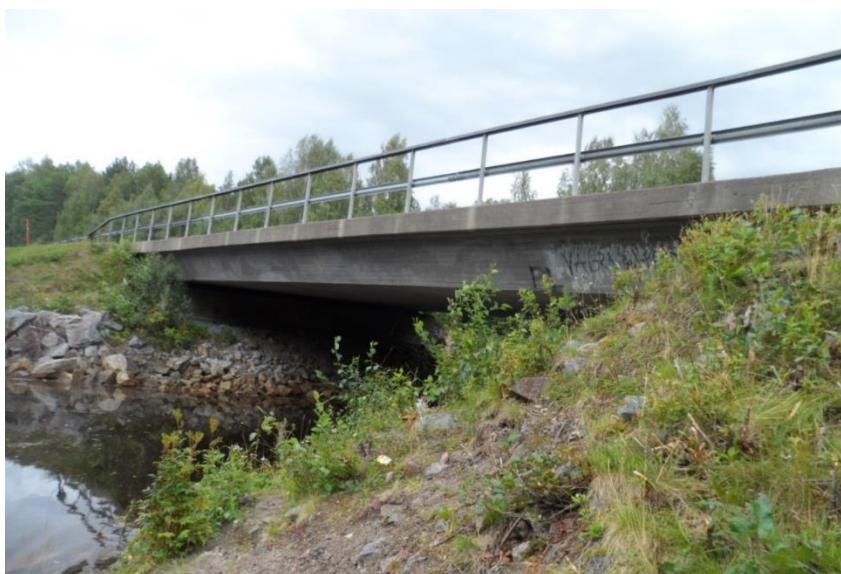
Figur 3.7.2. - Bro 25-243-1, Foto BatMan Trafikverket.
