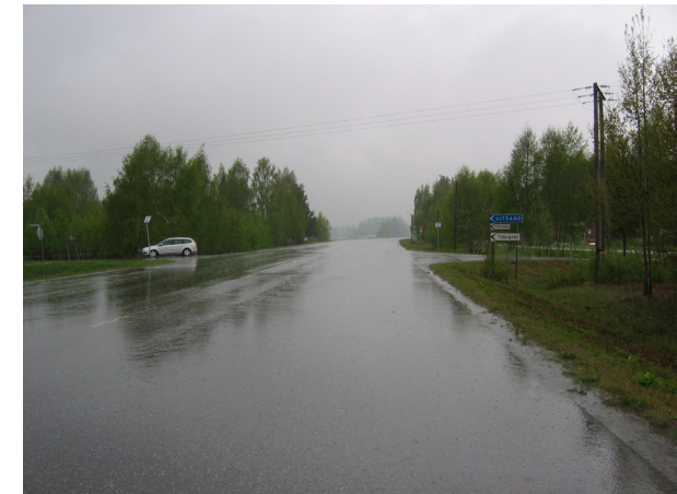
Korsningen mellan väg 373 och väg 930, taget från väg 373 mot väst.
