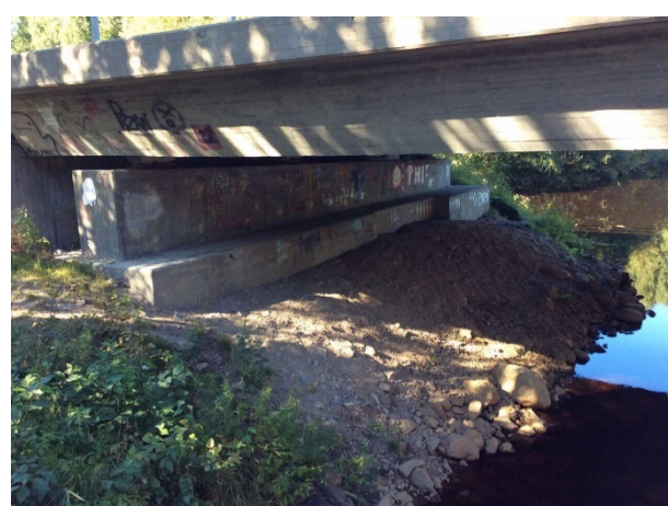
Figur 4.4.10. Faunapassage vid befintlig bro över Svensbyån.
