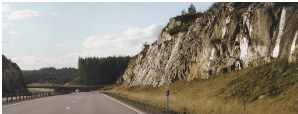
Bild 49. Se berget som en tillgång till skillnad från bilden nedanför. Foto: Vägen, en bok om vägarkitektur. Foto: Vägen. En bok om vägarkitektur.
