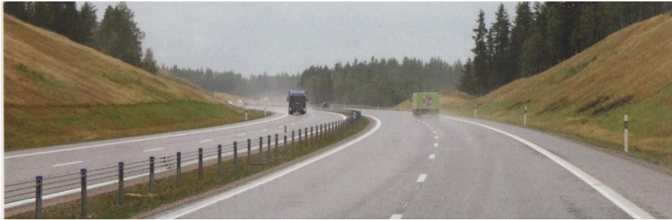
Bild 50. Här är berget söndersprängt och man har skapt stora grässlänter som inte passar in i skogsmiljön. Foto: Vägen. En bok om vägarkitektur.
