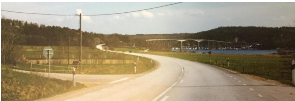
Bild 46. Exempel där väglinjen är lagd så att trafikanten får utblick över bron och vattnet. Foto: Vägen. En bok om vägarkitektur.
