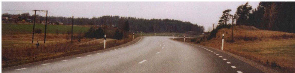
Bild 45. Exempel på där vägen inte följer landskapets former. Väglinjen skulle ha lagts 20 meter till vänster så hade man sluppit skära i åsen. Foto: Vägen. En bok om vägarkitektur.
