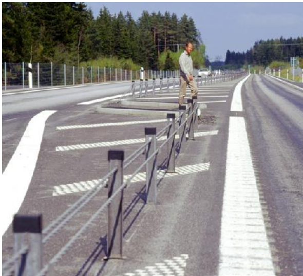
Exempel på mittö, där oskyddade trafikanter kan korsa vägen på ett trafiksäkert sätt via en avskiljande mittö.
