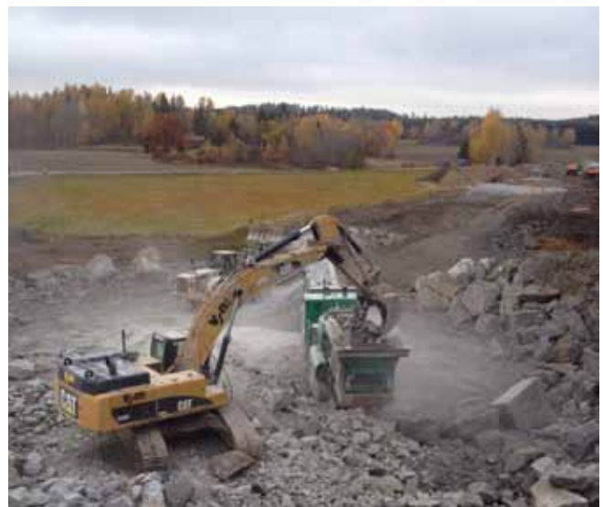
Krossning av berg på väg 49. Foto: Kurt Mickels.
