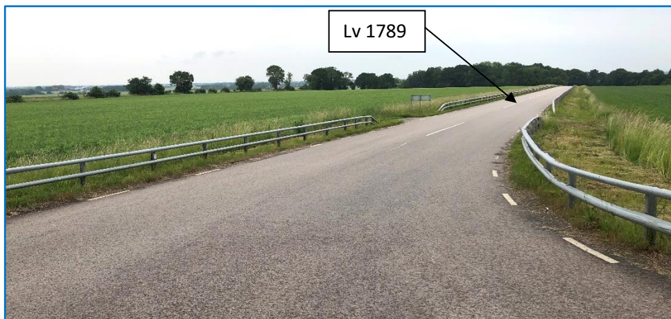
Figur 4. Lv 1789 i anslutning till korsningen med Lv 1788.
