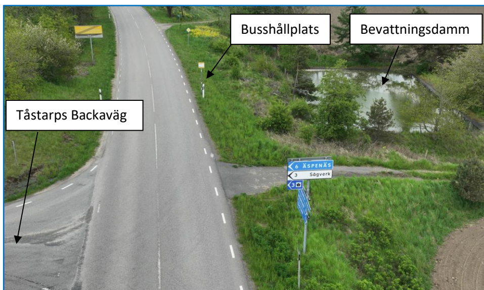
Figur 8. Befintlig busshållplats Tåstarps Backvägen (trafik mot Munka Ljungby) som är belägen i anslutning till korsningen Lv 1788/Tåstarps Backaväg utgörs av en busshållplatsskylt.
