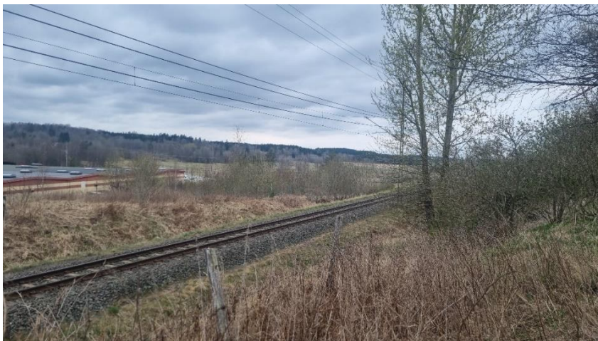
Figur 11. Miljön i direkt anslutning till spårområdet i höjd med verkstadsindustrier/metallfabrik på Metallvägen, strax söder om utredningsområdet. Vy åt nordväst.
