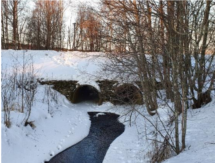
Figur 13. Dubbeltrummor utgör passagen över Bubäcken/Strömsbäcken.
