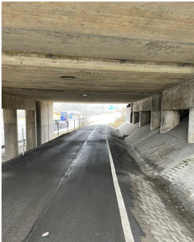
Figur 5.4. Gång- och cykelväg under järnvägen.
