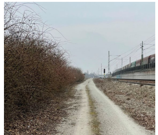
Figur 5.3. Befintlig serviceväg med buskridå.
