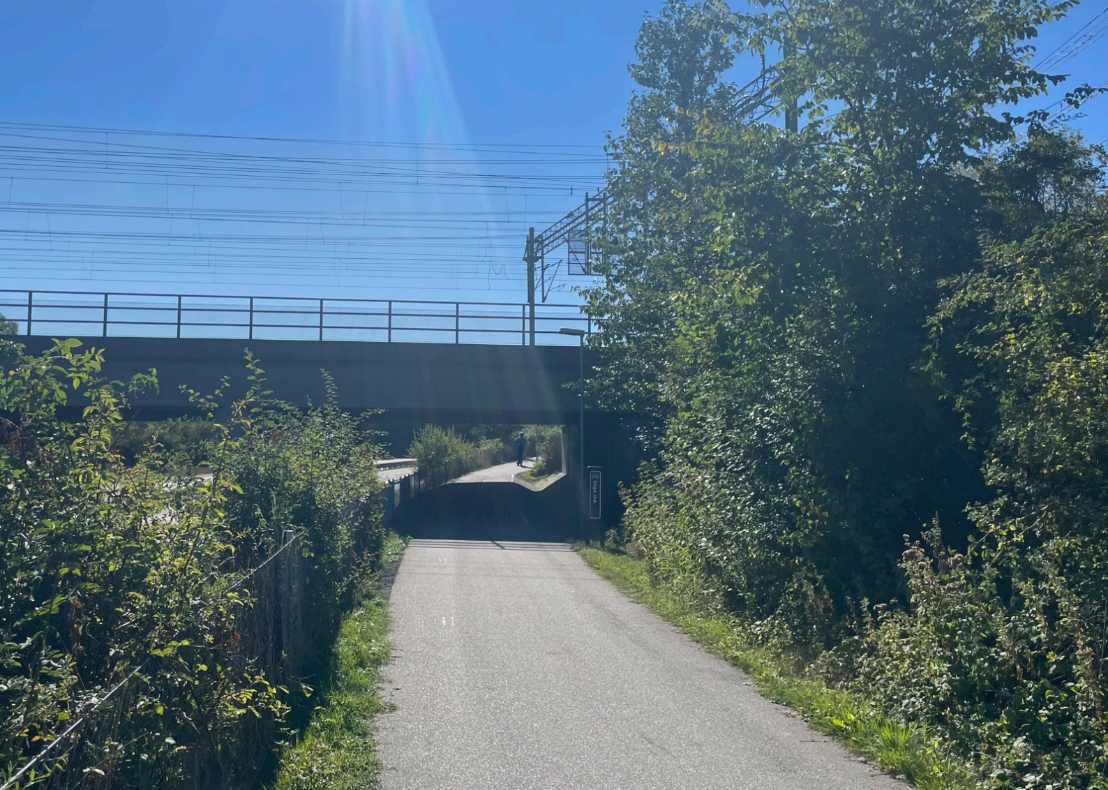
Figur 18- Foton från platsbesök 22-09-01 på passage under bron och omgivande grönska som döljer byggnadsverk samt stora delar av den dominerande infrastrukturen. Grönskan bidrar till en positivare upplevelse av platsen och är därför viktig att återetablera efter anläggning.
