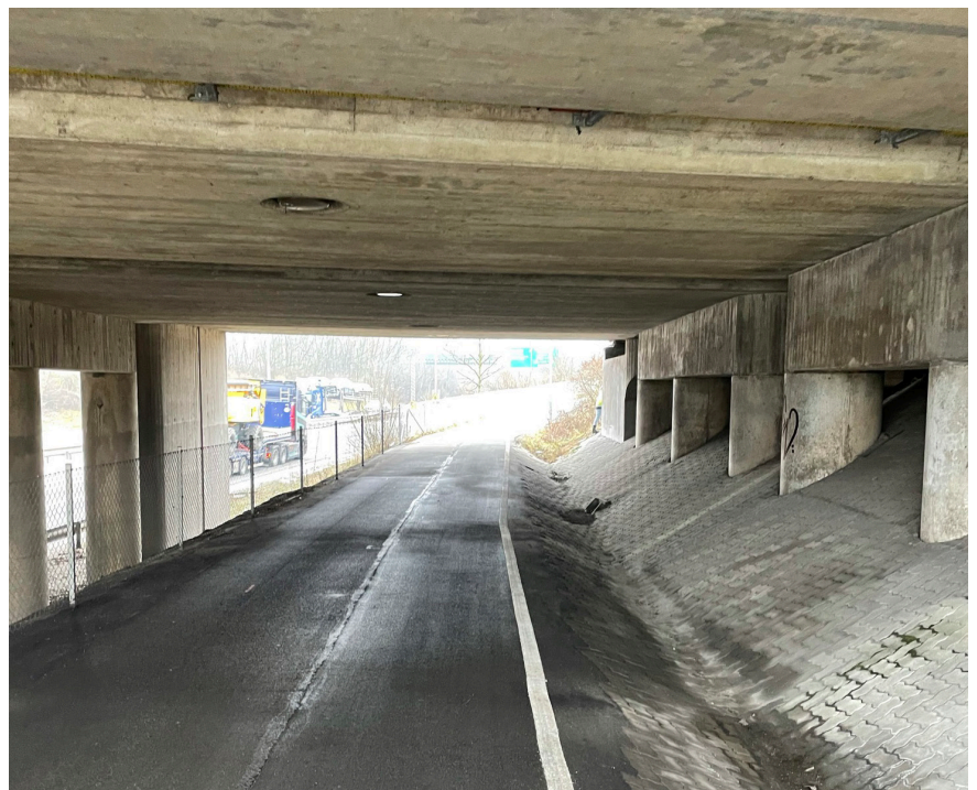
Figur 16- GC-väg under järnvägen
