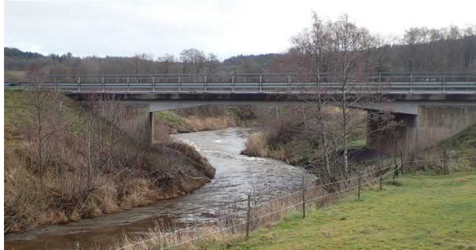
Figur 39 Befintlig bro över Surtan med plats för viltpassage.
